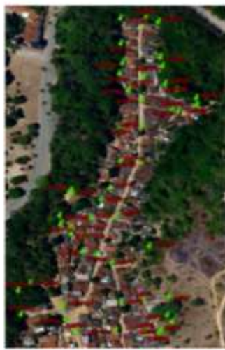
Fig. 5 Pontos de Controle GPS Fonte: Arquivo UFPE, 2014.
