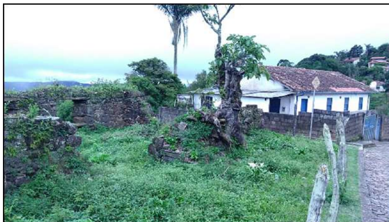
Imagem 5. Ruína dentro de bairro da Serra de Ouro Preto com casa ao fundo – Foto: Autor.
