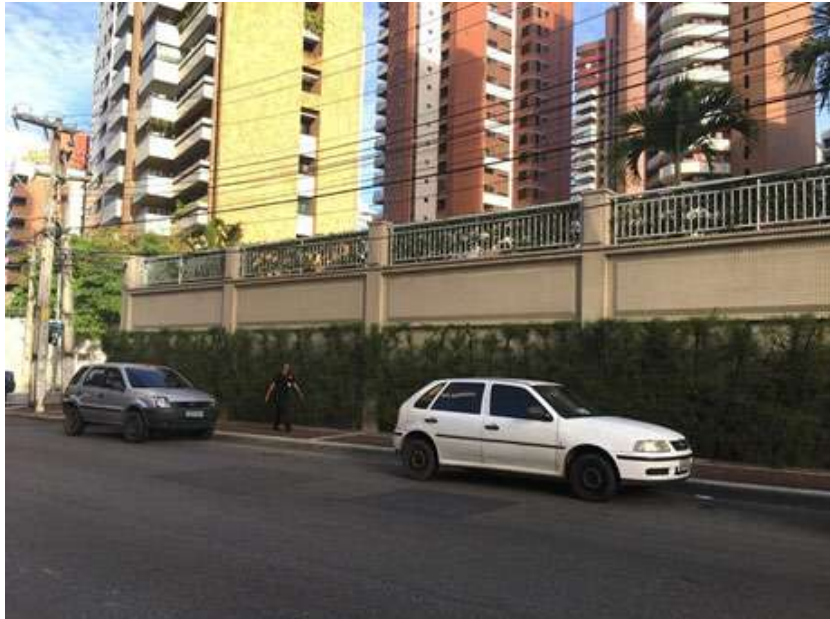
Figura 10. Fotografias dos muros de edifícios residenciais multifamiliares localizados no bairro Meireles, Fortaleza-CE, Brasil. Fonte: Acervo pessoal (2017).
