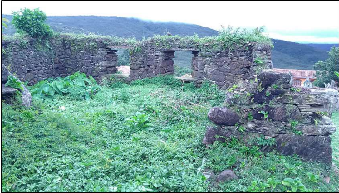
Imagem 6. Ruína dentro de bairro da Serra de Ouro Preto com casa ao fundo – Foto: Autor.
