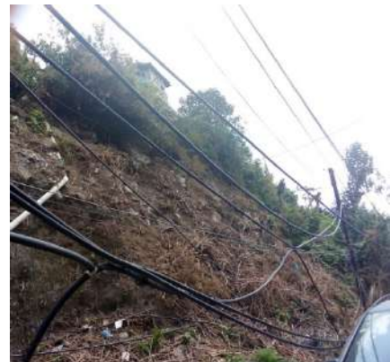
Fotografía 2. Mangueras de agua, Colonia Tierra Colorada, Tlalpan Fuente: propia.
