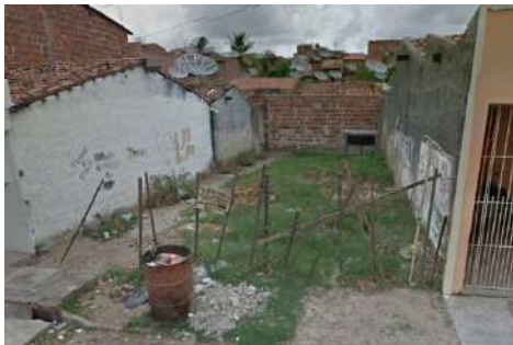
Figura 5. Espaço Criativo Jardim antes do início das obras.
