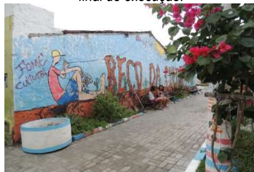
Figura 8. Alameda em fase final de execução.
