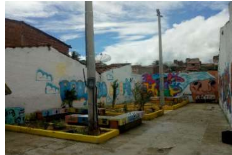
Figura 6. Espaço Criativo Jardim em fase final de execução.
