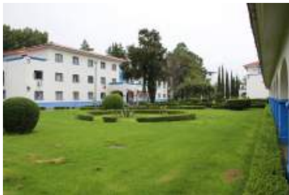
Figura 2 Departamento de Internado de la UACH.
