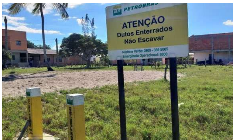
Figura 1. Dutos na comunidade de Degredo, Linhares - ES. Fonte: Redes de Conhecimento/Redes de Cidadania.
