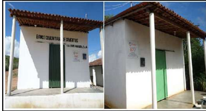
Figura 6. Vista parcial externa de BSCs visitados.
